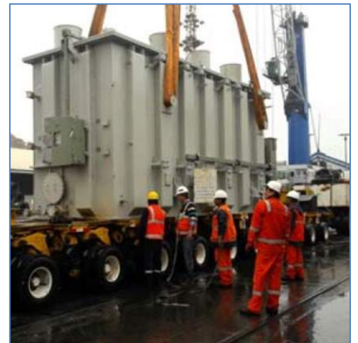
Llegada a puerto de los transformadores
