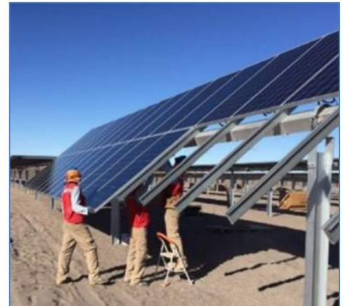
Montaje de paneles
