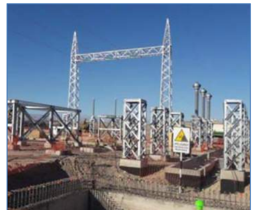
Montaje de estructuras y equipos de patio
